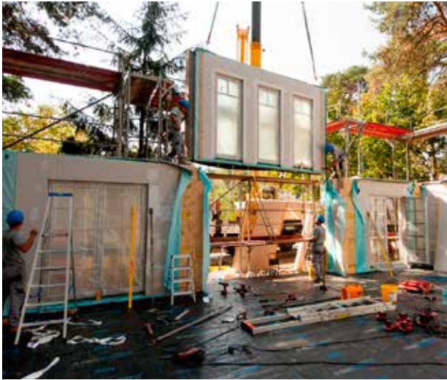
Anschließend wird das Obergeschoss aufgesetzt.
