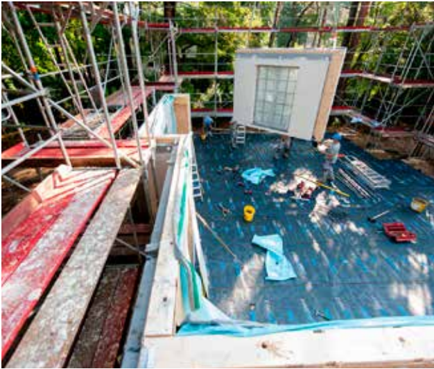
...und das Erdgeschoss auf das Fundament montiert.
