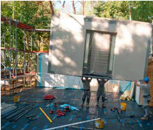
... auf LKW zum Bauplatz transportiert...
