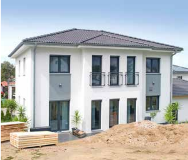
Nach ca. 12 Wochen ist die Villa fertig...
