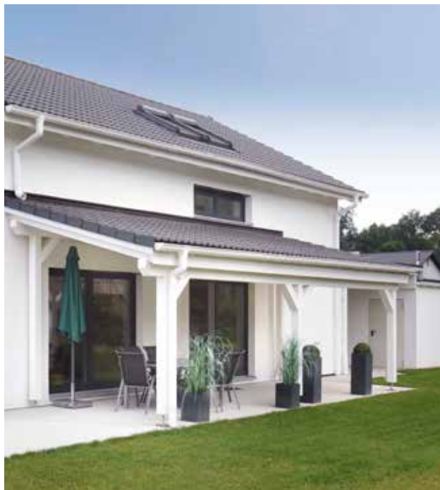
Solides Dach über der Terrasse
